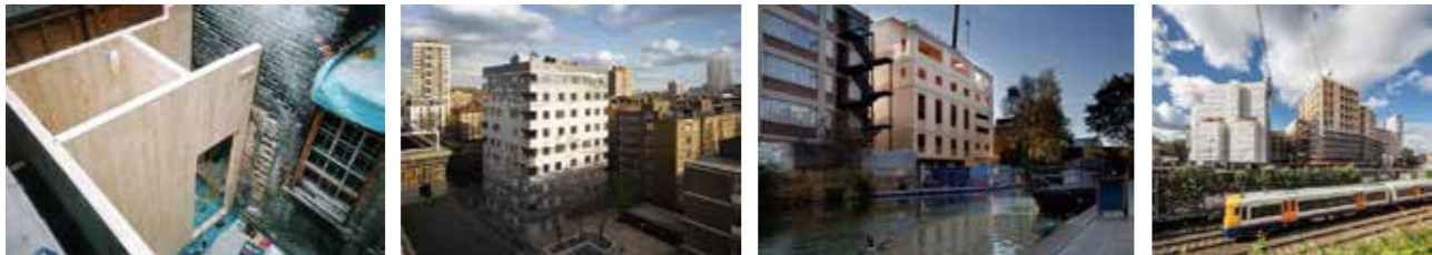
図1 2003年、英国初のCLT建築。南ロンドンのハットリ・ジョウジ邸、3階建て45m 2 の増築工事。大工3人によって運搬車両から直接パネルを吊り上げ、わずか半日で精確に施工された。 図2 2009年、9階建集合住宅のStadthaus竣工。毎年9月、建物の前ではオープンハウスイベントに合わせて木質建築の公開トークを行う。住民自らが彼らの住まいのよさ：防音性、快適な室内温熱環境、住み心地そのものについて語る。プロジェクトを重ねるに従い、木材が石やコンクリートとは異なる熱力学的傾向を有することが明らかになった。 図3 精密なプレカット技術は20世紀までの従来方法を超える高い精度で現場での組み立て施工を実現した (Whitmore Road)。 図4 最新プロジェクトDalston Lane。延床面積17,000m 2 の10階建集合住宅。設計事務所の3D図面データはエンジニア、CLTプレカット工場と共有された。デジタルな直結により、建築家は単なるグラフィックデザイナーではなく、再び施工プロセスへ深く関与する。ミスなら何と言ったのだろうか？
